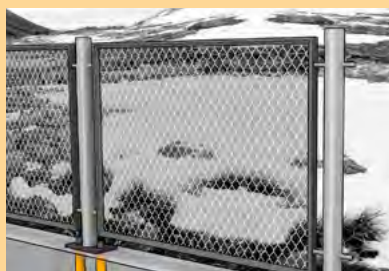
Kaiteiden jälkiasennukset perusmuureihin
